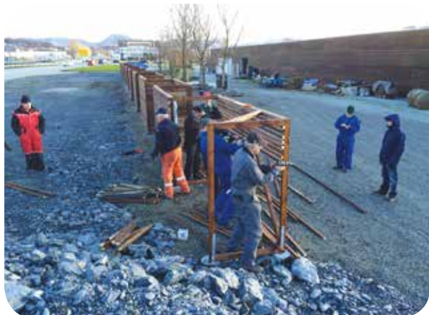
Nytt gjerde ved driftsbygningen
